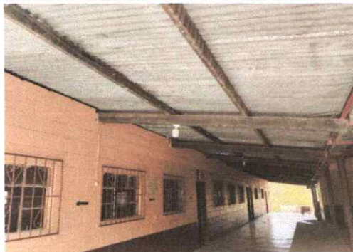
Foto 5. vista del modulo corredor, se propone cambiar techo de lamina troquelada cal.26, mantenimiento de la estructura portante pintandolas de color rojo.
