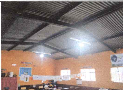
Foto 3. Vista del modulo 1 aulas, lo cual se propone colocar 4 bombillas por aula y cambio de tomacorrientes y apagadores, asi como cambio decable cal.10
