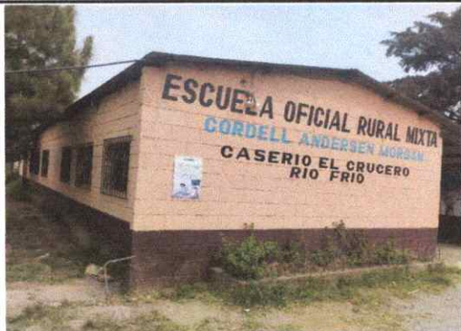
Foto 1. vista del modulo 1 tres aulas y cocina, la cual se propone cambiar el techo por lamina troquelada cal.26.
